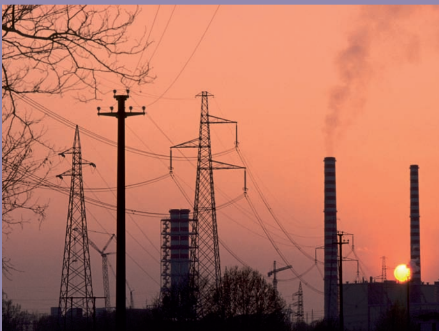
Secondo il Rapporto GSE l'energia geotermica nel 2010 ha contribuito per l'1,5% alla produzione energetica nazionale del nostro Paese.
